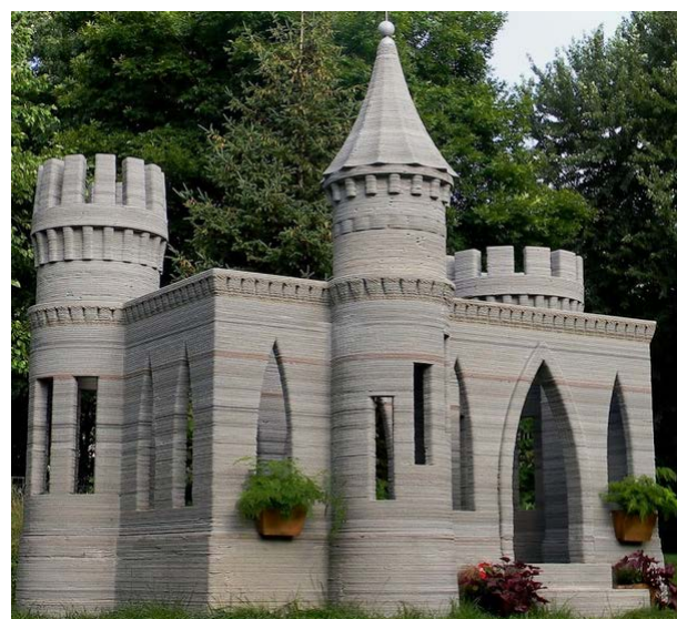
Рисунок 31 – Будинок із бетону, виготовлений за адитивними технологіями
